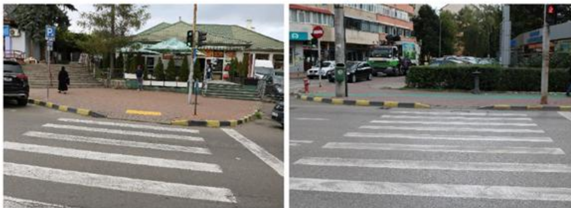
Figura 2.5.53 Treceri de pietoni accesibilizate (exemplificare)
