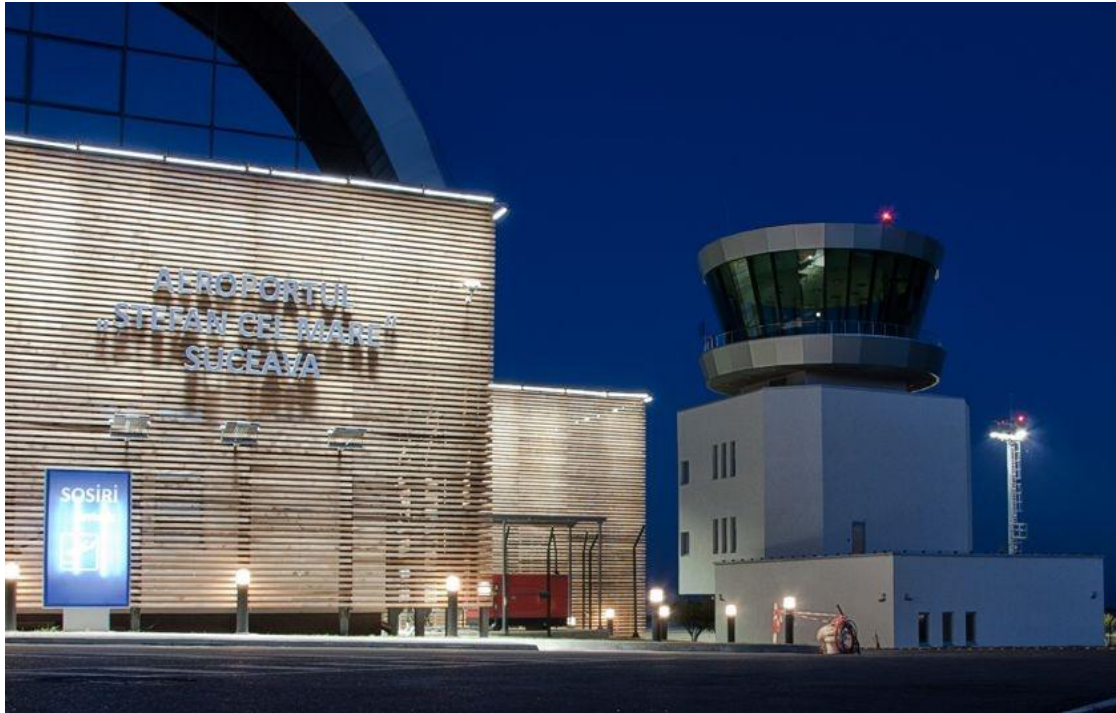
Figura 2.5.39. Terminalul Aeroportului Internațional Suceava
